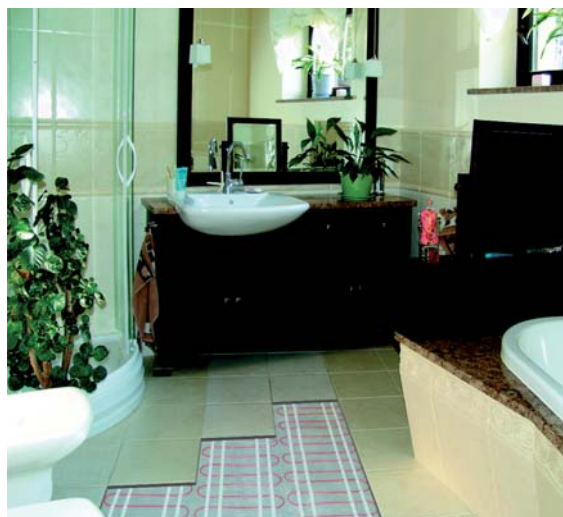
Rys. 2. Wielu inwestorów i potencjalnych użytkowników decyduje się na montaż ogrzewania podłogowego w pomieszczeniach z zimną podłogą z terakoty lub kamienia jak łazienki czy kuchnie
