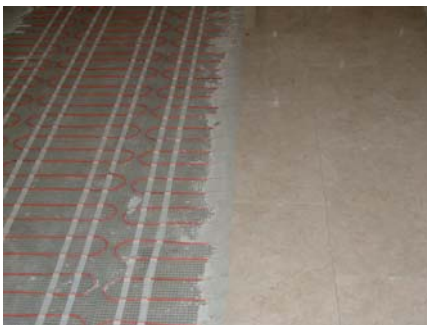
Rys. 3. Kolejne etapy montażu instalacji elektrycznego ogrzewania podłogowego
